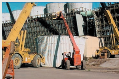
Installing fan cylinders
